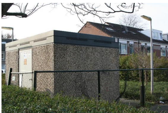
Figuur 5: Voorbeeld van een middenspanningsruimte in Zoeterwoude-Rijndijk (Kopperwetering)
